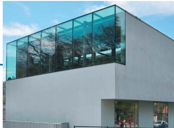
FELSENAU Innenausbau Metallbau Spengler
